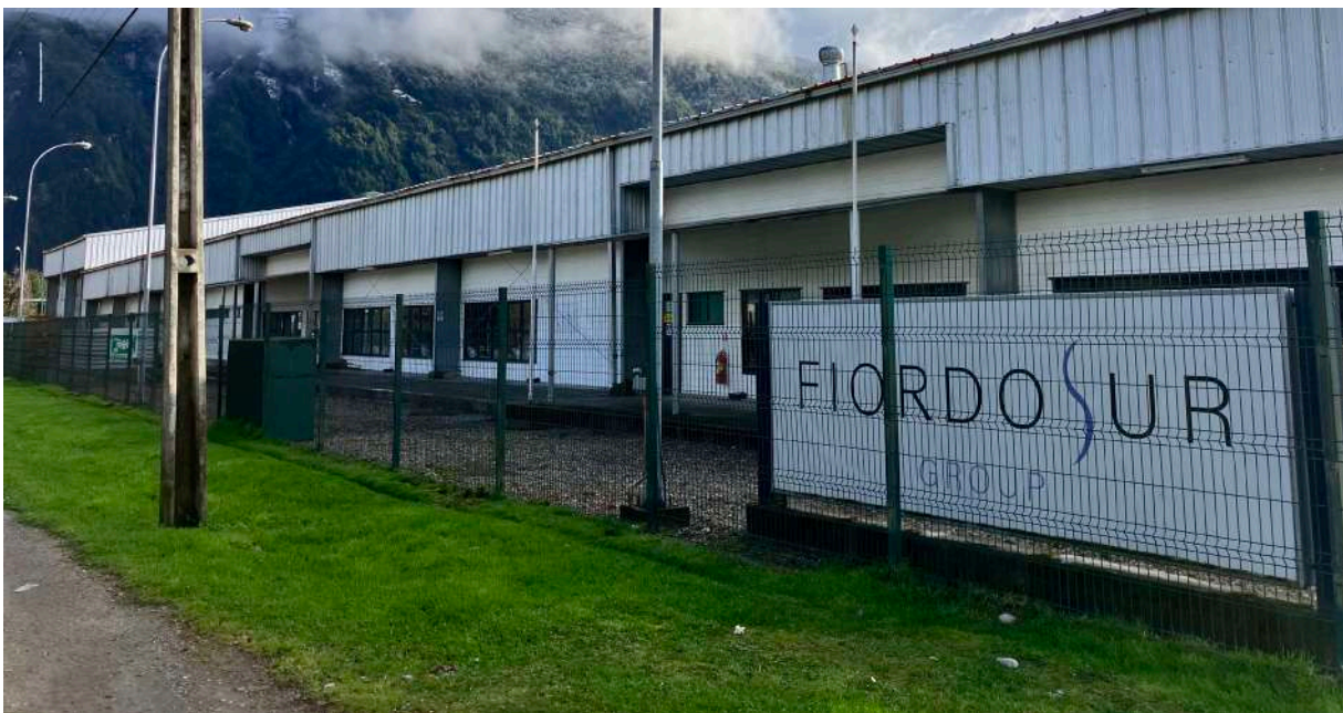
IMAGEN 33.- PLANTA DE PROCESOS FIORDO SUR EN PUERTO AYSÉN.
