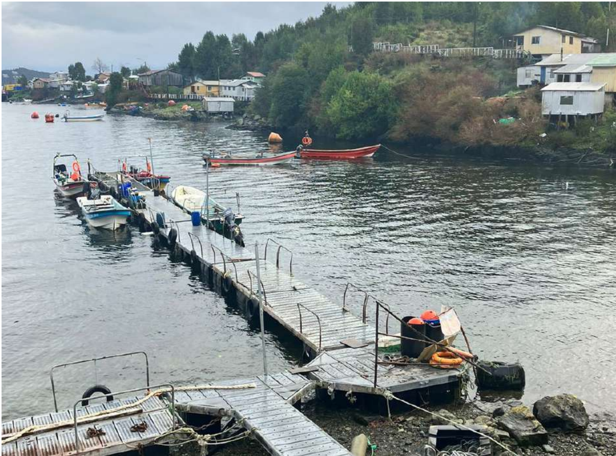
IMÁGEN 27.- MUELLE EN PUERTO GAVIOTA. VISITA JULIO 2023.
